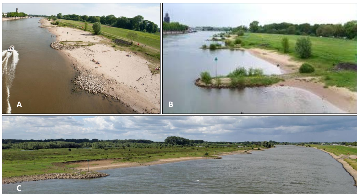
Figuur 2.5 – Enkele natuurvriendelijke oevers in de Ossewaard bij Deventer, bij laagwater (A) en hoger water (B). Een verschil in helling is te zien tussen het bovenste deel van de oever, bedekt met vegetatie, en het talud richting de vaargeul. In C) is het verschil te zien tussen een eroderend kribvak en een kribvak dat nog vast ligt. In dit eroderende kribvak is een flauwere helling ontstaan dan in het verdedigde kribvak, eindigend in een steilwand (Van Winden, 2011).
