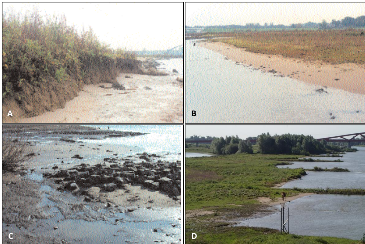
Figuur 2.4 – Een paar voorbeelden van de typerende morfologie die zich ontwikkelde na het verwijderen van de oeverbescherming, met een steilwand (A) en een strand met een flauwe helling (B) geobserveerd in 2000. Een aantal kribben is beschadigd zodat er water achterlangs kan stromen (C), zoals geobserveerd in 2003 (RIZA, 2003). In D) is de typische morfologie van de kribvakken in 2014 te zien, met een duidelijk verschil in erosie in een kribvak (foto: Margriet Schoor).
